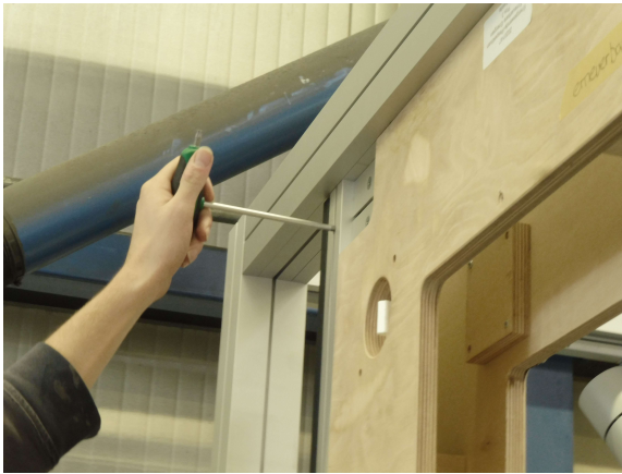
Wandelemente einstellen und verschrauben Adjust and screw the wall elements
